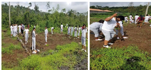
Figura 4. Construcción de un aja shuar en las instalaciones de un establecimiento educativo de Macas
